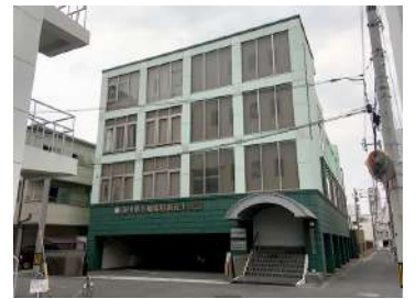
写真は、「土地家屋調査士会館」です。 三越の北側にある、チョッと変わった色 (緑色)の建物です。
